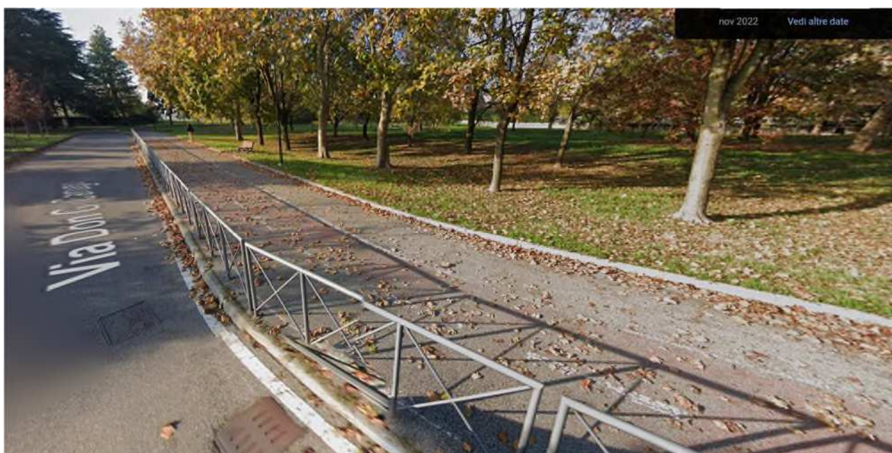
Figura 27 Via Don Carugo: area limitrofa al collettore da risanare
